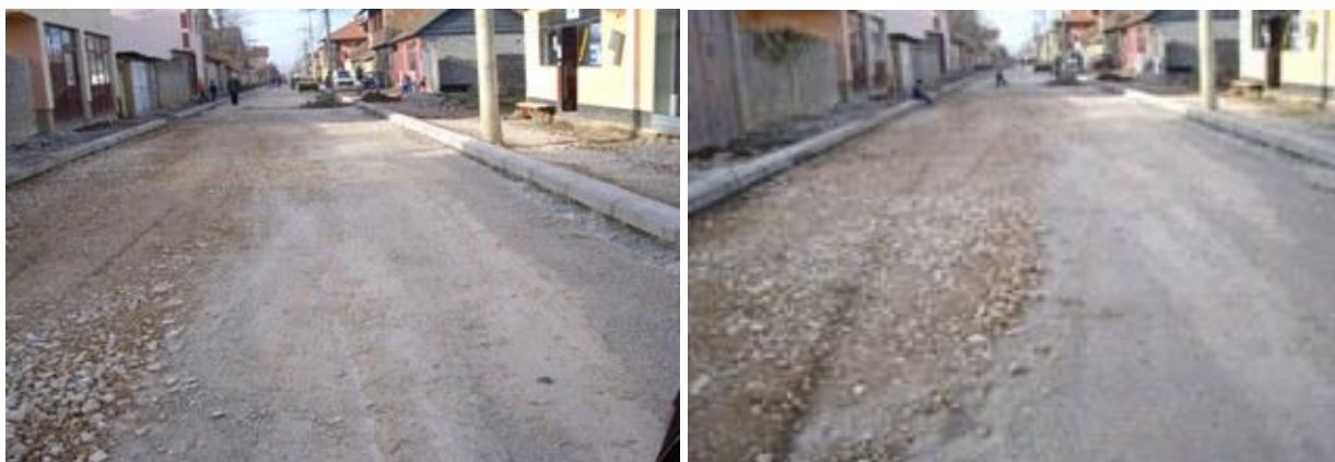
Asfaltimi i rrugës „Jashar Salihu” Prizren
