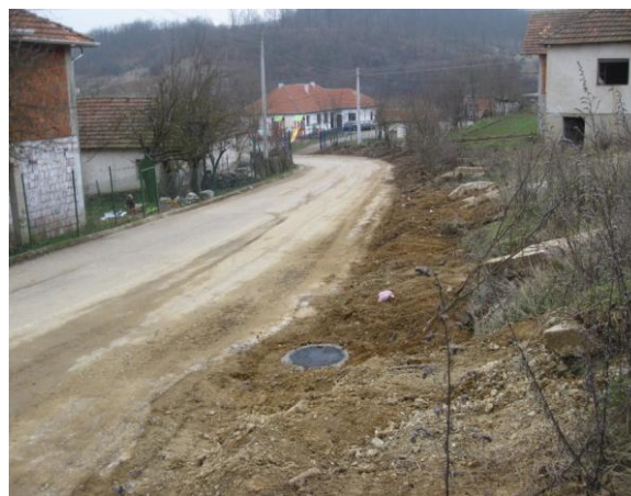
Ndërtimi i rrjetit të kanalizimit ne Makresh të Epërm ne Gjilan
