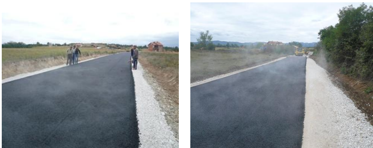
Asfaltimi i rrugës Dumnicë – Llaushë
