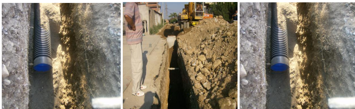
Ndërtimi i kanalizimit në Vrellë- Studenicë
