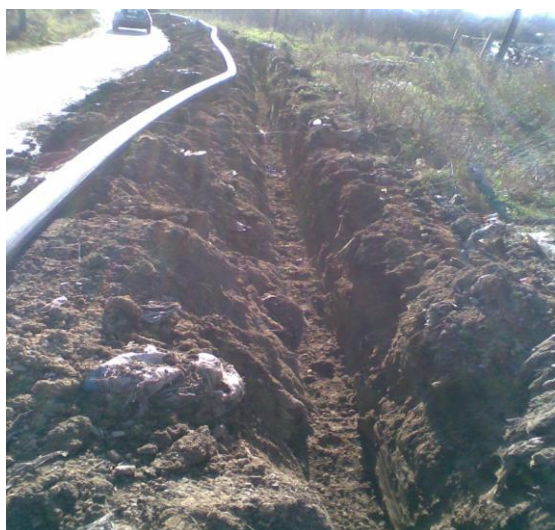
Rrjeti i pakompletuar i ujësjellësit ne Kufc të Epërm” ne Gjilan
